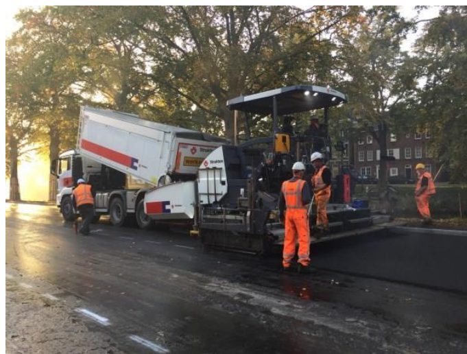
Figuur 2: Aanbrengen Greenfalt te Breda
